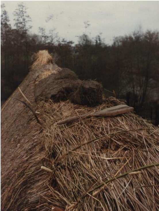
en wordt met een dikke laag aangebracht.
